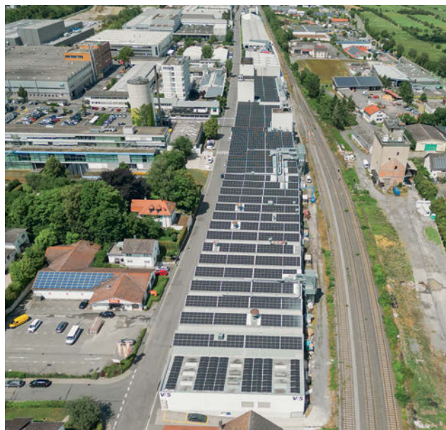
Die PV-Anlage auf Werk 1
