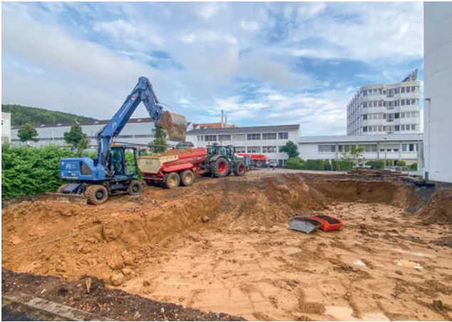
Baufortschritte des neuen Kesselhauses von August 2025 bis Juli 2026
