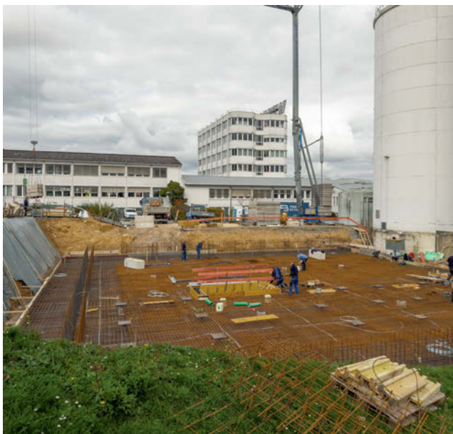
Baubeginn von Kesselhaus 2 im August 2025
