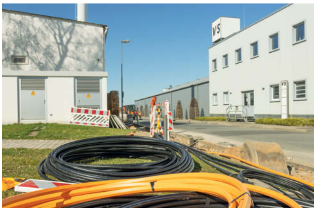
Bauarbeiten zum Ringschluss
